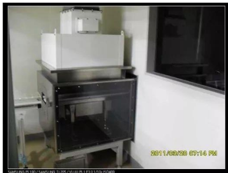
抗生素无菌室与一般区的连接——采用阳压箱
